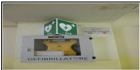
CORRIDOIO INGRESSO PALESTRA
